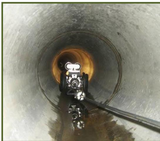
*Illustration 5 : Passage caméra pour l'inspection des réseaux*
