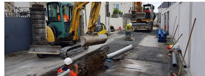
2019 : Pose des réseaux d'eau, d'assainissement et de fibre sur la D212 à Beuste.
