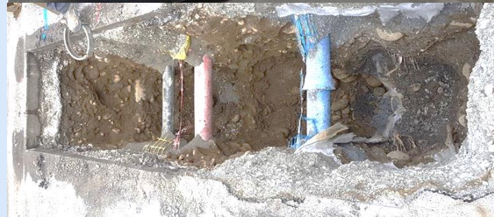
Mise en place de l'assainissement collectif au niveau des branchements avec des terrassements sécurisés par 2 aspiratrices-excavatrices (pour ne pas endommager les réseaux et travailler en sécurité).
