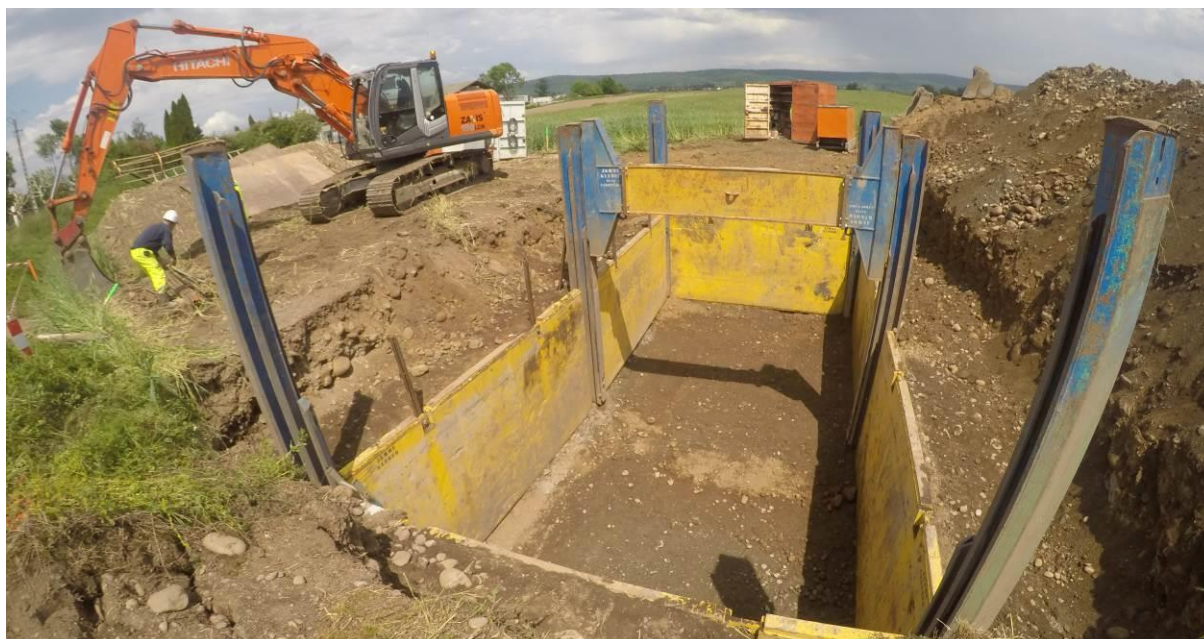
Illustration 13: Pose de réseau EU, AEP en forage horizontal sous voie ferrée à Mirepeix
