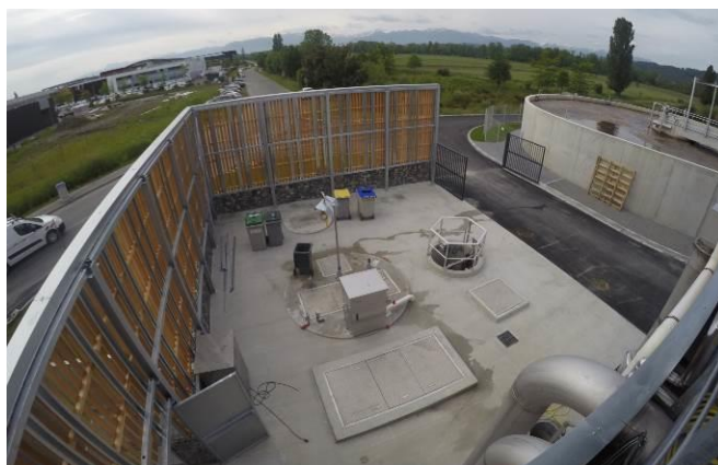
Illustration 6 : Poste de relevage de la Step d'assat:
