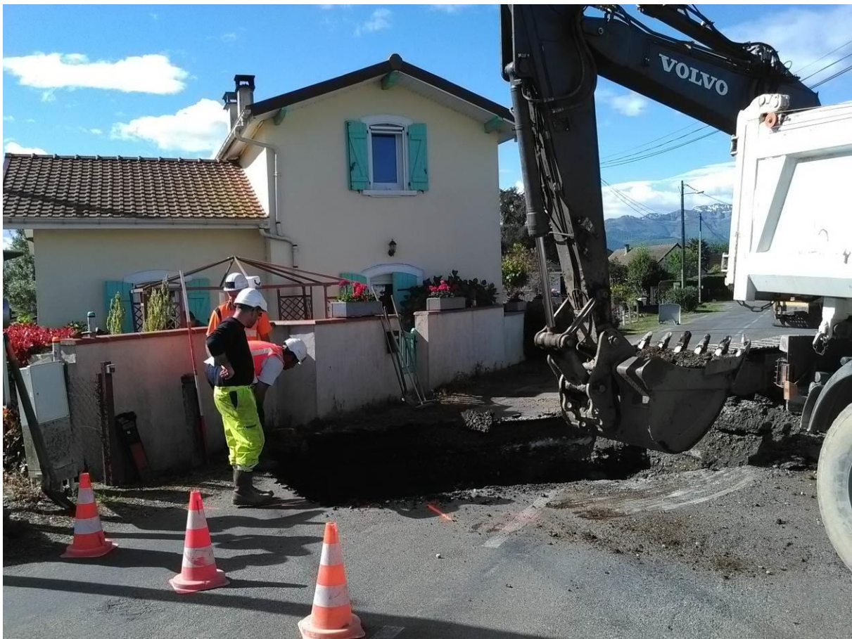
Illustration 13 : Déconstruction de la STEP Bénéjacq et transformation en bassin et poste de refoulement et passage de ce dernier sous voie ferrée à Mirepeix
