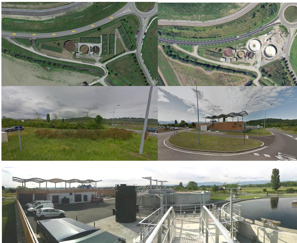
Station d'épuration d'Assat-Bordes
