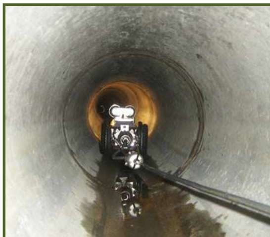
Illustration 5 : Passage caméra pour l'inspection des réseaux
