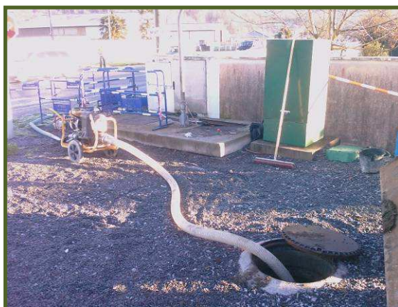
Illustration 4 : Réhabilitation PR Des Granges à Bordes
