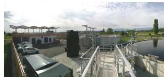
Nouvelle station d'épuration d'Assat (15 000 EH ou Equivalent Habitant)
