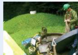
Nettoyage du réservoir d'eau potable de Coaraze (Bas Service)
