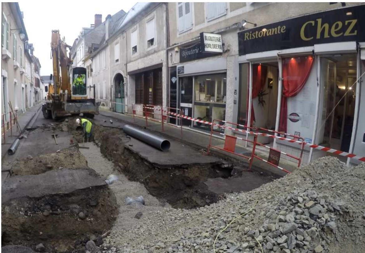
Illustration 13b : Réhabilitation du réseau unitaire (EU+EP) avec la Ville de Nay - Rue Notre Dame
