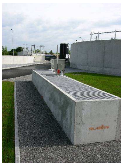
Illustration 1: Chenal de comptage des Eaux traitées sortant du clarificateur à Assat et point d'auto surveillance (prélèvements pour analyse et mesure de débit)
