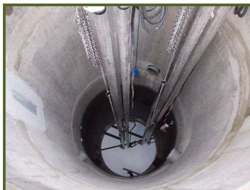
Illustration 6: Poste de relevage de la Step de Montaut:
