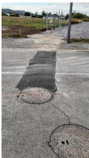
Réalisation d'un branchement à l'aide d'une aspiratrice excavatrice depuis un regard de visite d'assainissement sur la commune d'Assat (Zone Aéropolis).
