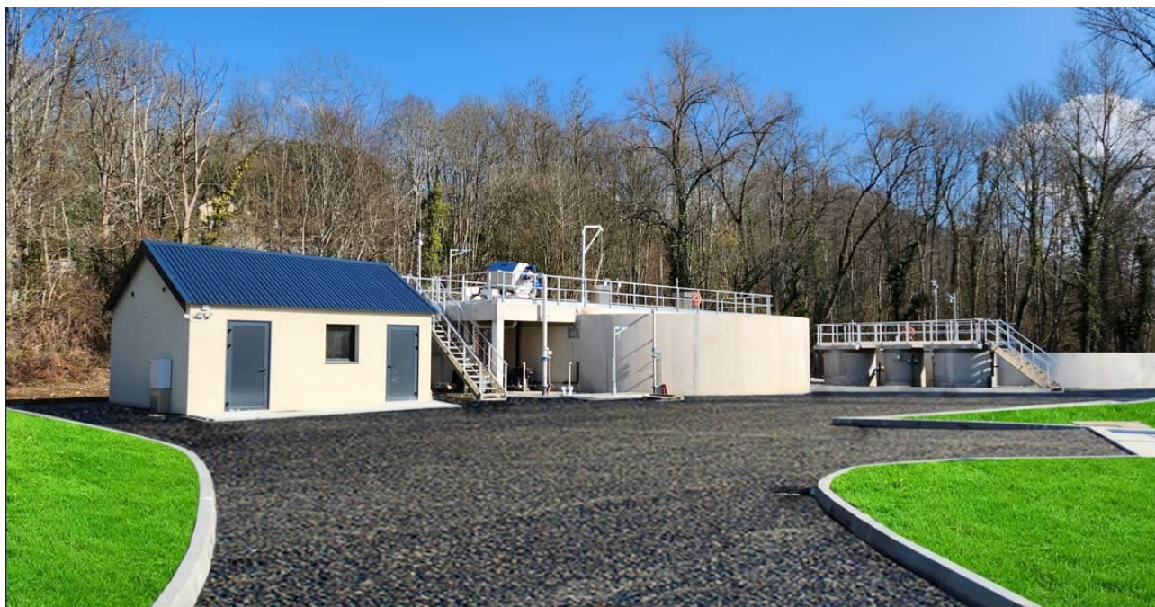
Nouvelle station d'épuration d'Asson de 2000 EH (travaux en 2022 pour fin avril 2023)
