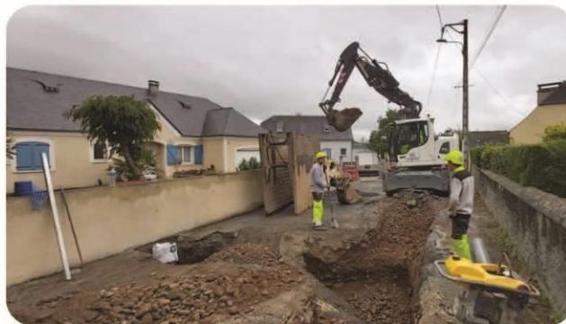
Création d'un branchement d'eaux usées à Lagos
