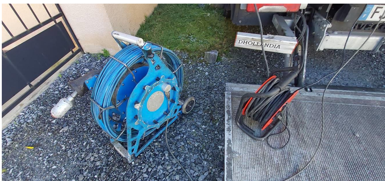
Passage de caméra dans les réseaux.
