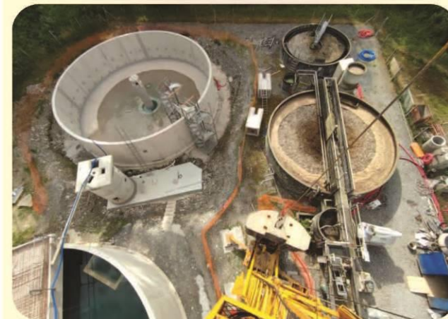
Nouveaux bassins (à gauche) et anciens ouvrages (à droite) vus depuis la grue de chantier.
