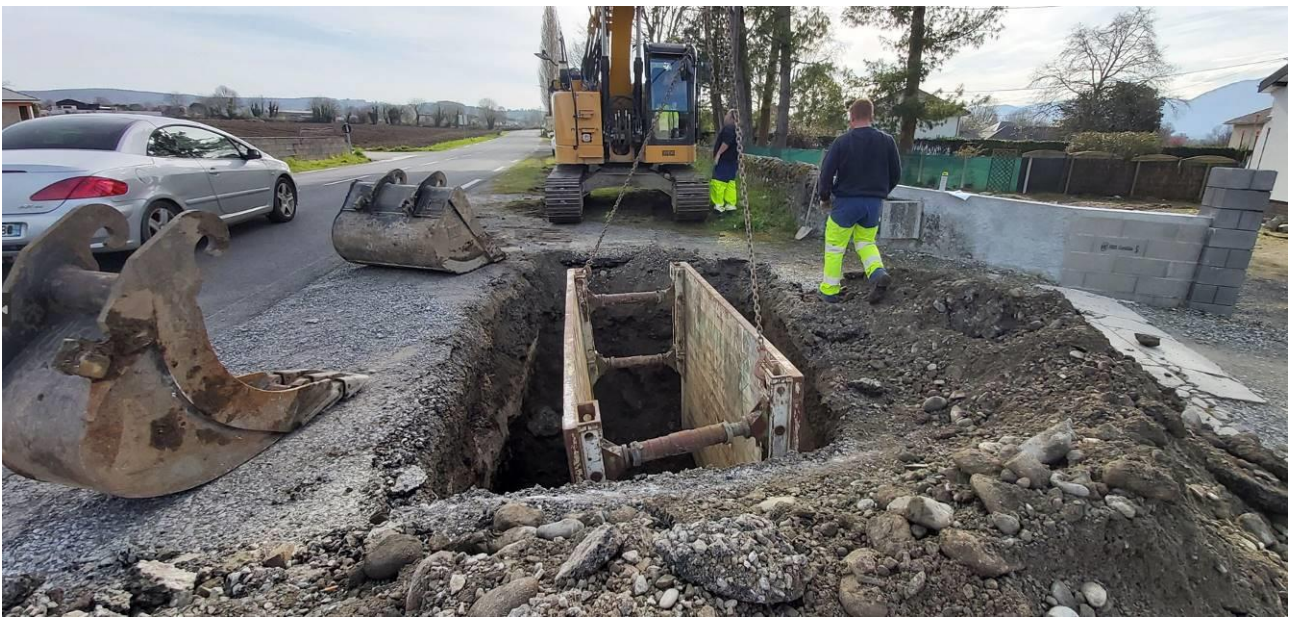
Réparation d'une canalisation d'eaux usées chemin de la Montjoie à Nay à 2.50m de profondeur
