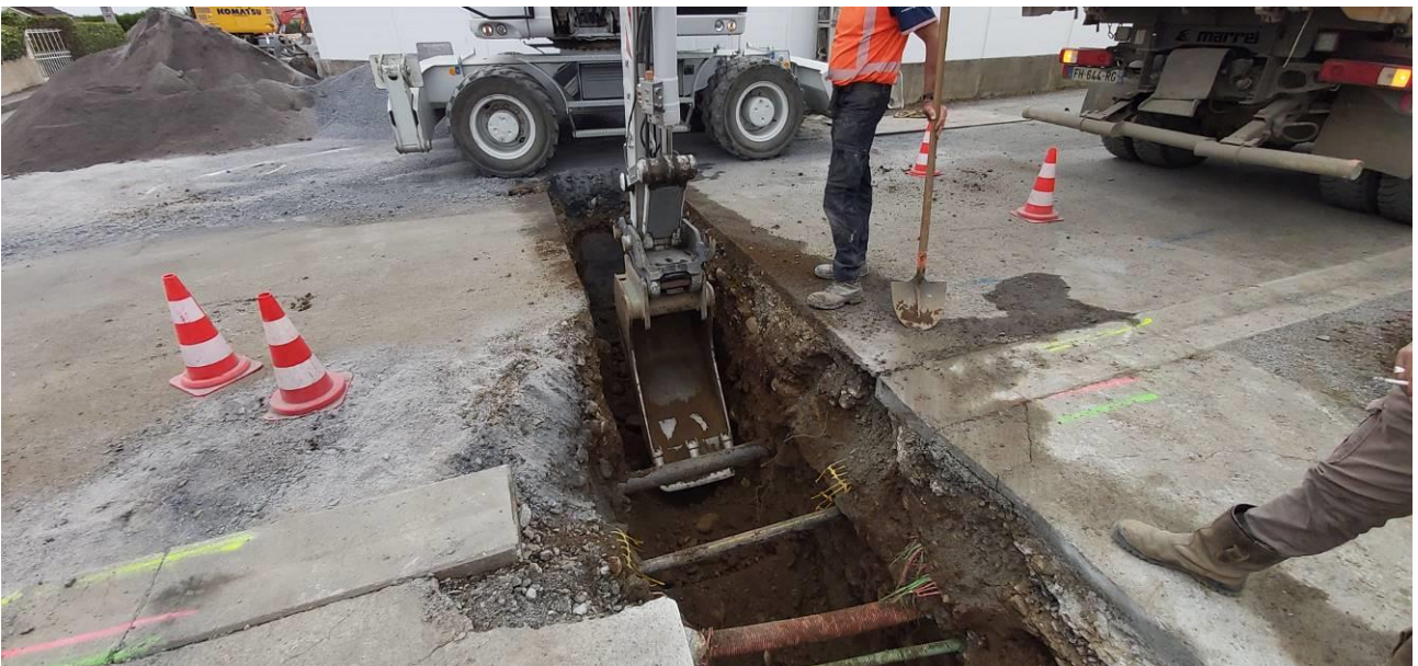
Travaux de création du réseau d'assainissement et renouvellement du réseau d'eau potable à Lagos (fin de l'opération) (ici : un branchement avec croisement de réseaux divers)
