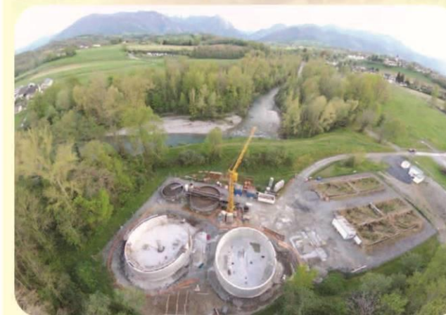
Vue du chantier avec un drone (crédit photo : Mairie d'Asson)
