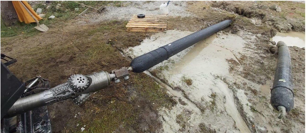
Forages dirigés pour passer les réseaux d'eau et d'assainissement sous l'Ouzom à Igon
