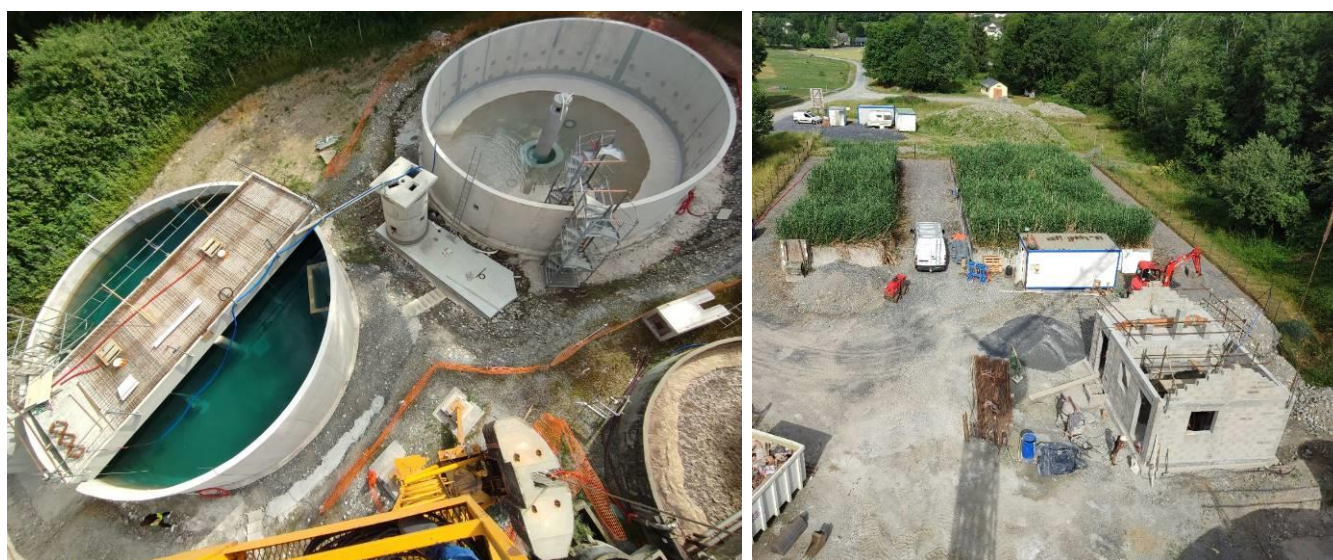
Travaux d'extension de la station d'épuration de la commune d'Asson de 1000 à 2000 équivalents-habitants (à gauche : nouveaux bassin d'aération et clarificateur / à droite : local technique et vue sur les lits de roseaux pour les boues)
