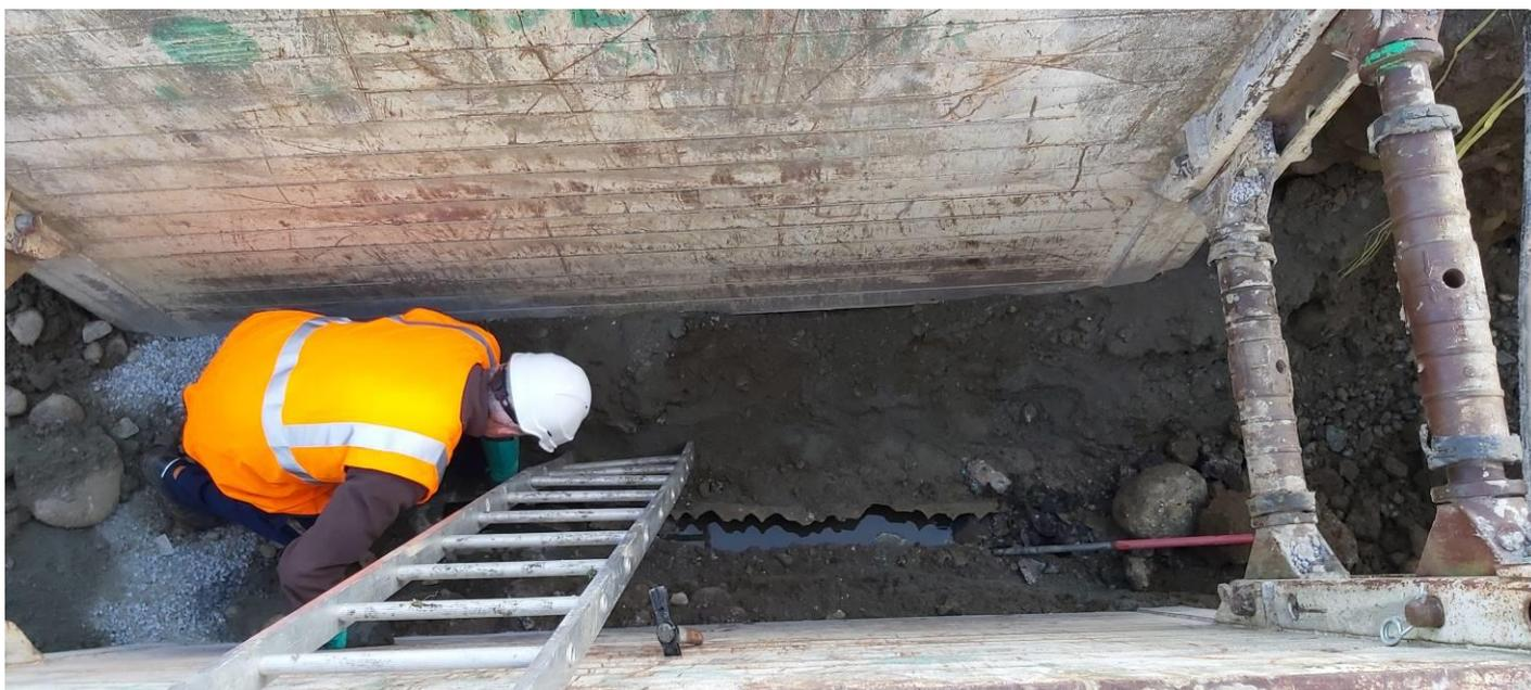
*Réparation d'une canalisation d'eaux usées en amiante-ciment effondrée à Nay à 3m de profondeur (Remplacée sur le tronçon par du PVC CR16).*
