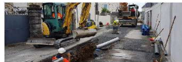
2019 : Pose des réseaux d'eau, d'assainissement et de fibre sur la D212 à Beuste.
