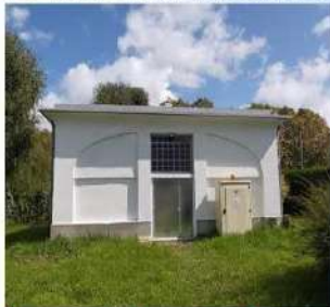
Forage de Lestelle-B
