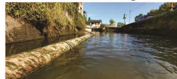
Audit de vérification du réseau EU posé en 2015 dans le canal de la Grau à Nay
