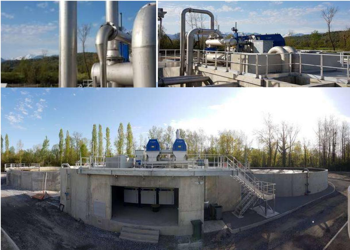
*Bassin d'aération – plateforme des Trommels (tamis à tambours) et compresseurs à vis pour l'oxygénation du bassin dans le local - STEP de Baudreix*
