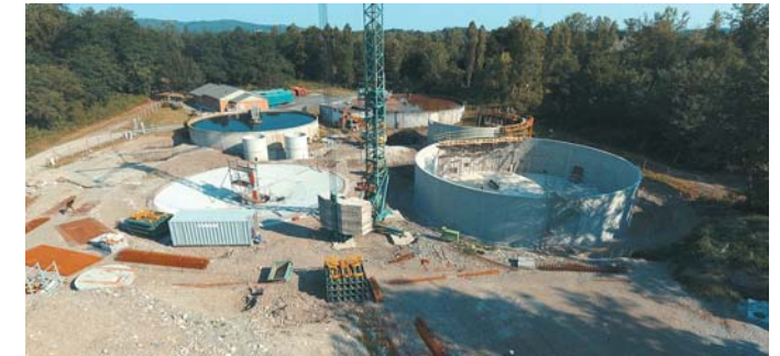
Extension de la station d'épuration de Baudreix (20 000 EH)
