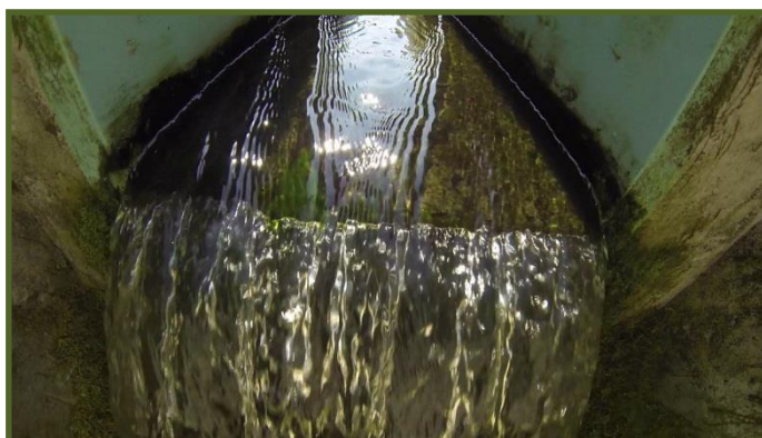
Illustration 1: Eau traitée sortant du clarificateur à Baudreix
