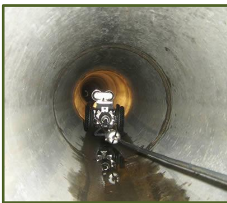
Illustration 5 : Caméra pour l'inspection des réseaux
