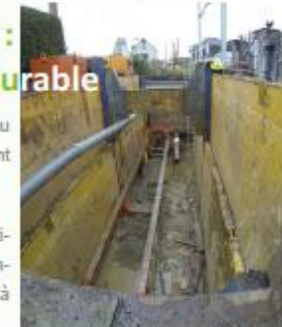
Forage (EUAEP) sous voie ferrée
