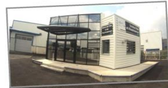
Maison de l'Eau et de l'Assainissement à Bénéjacq
