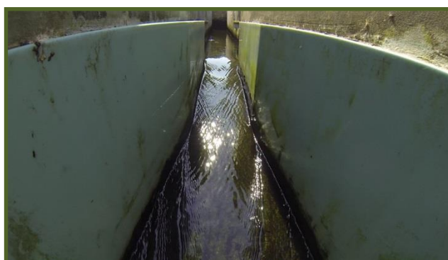
Illustration 10: Canal de sortie des eaux traitées de la Step de Baudreix
