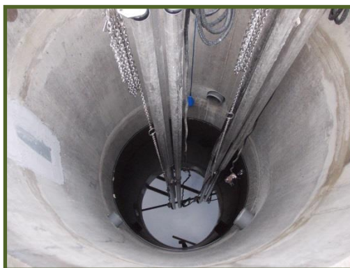
Illustration 6: Poste de relevage de la Step de Montaut:
