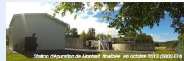
Station d'épuration de Montaut finalisée en octobre 2013 (2000 EH)
