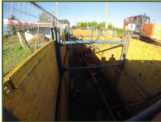
Illustration 13: Pose de réseau EU, AEP et Gaz en forage horizontal sous voie ferrée à Baudreix
