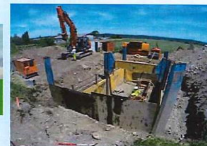
Pose de conduites eau et assainissement sous la voie ferrée à Mirepeix
