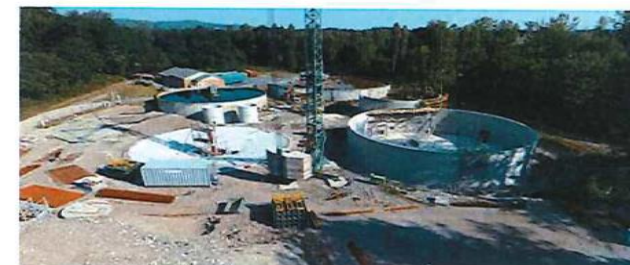
Extension de la station d'épuration de Baudreix (20 000 EH)
