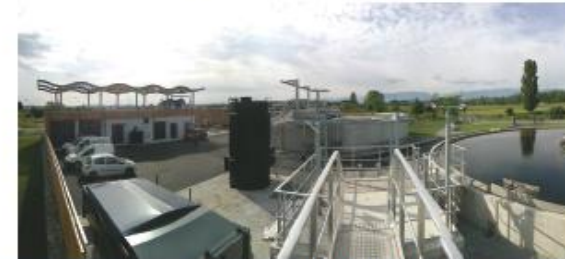
Nouvelle station d'épuration d'Assat (15 000 EH ou Equivalent Habitant)
