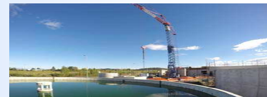
Travaux en cours pour l'extension de la STEP Assat-Bordes
