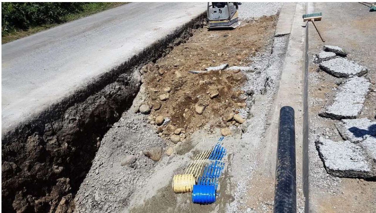
Illustration 1 : Pose du réseau d'assainissement à Baudreix avec 20% de réemploi de matériaux autochtones
