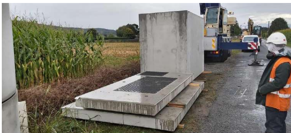
Poste de relevage principal de Beuste (Cimetière) éléments de la chambre de vannes et dalles du poste
