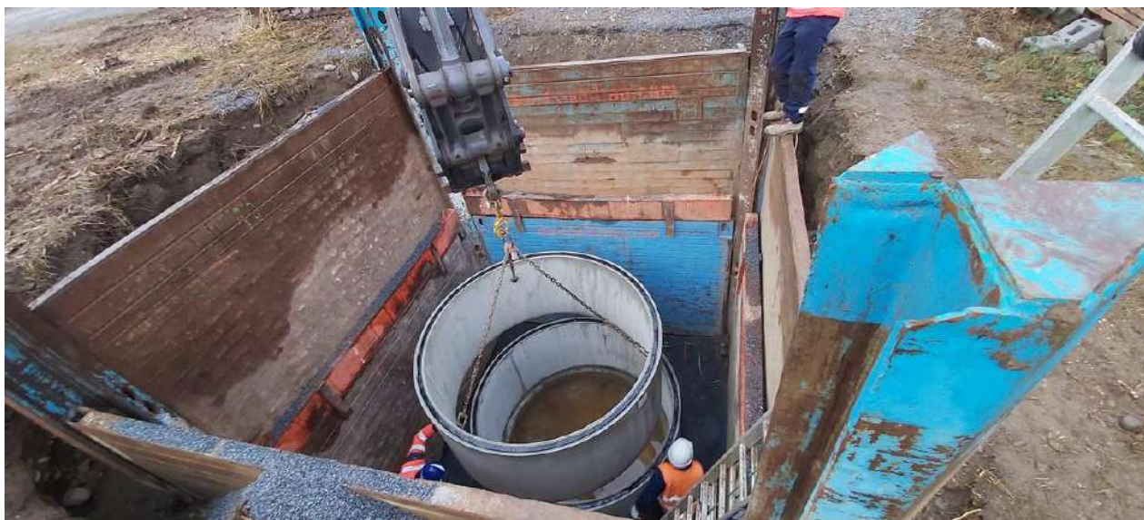
Création du réseau d'assainissement des eaux usées à Beuste (Mise en place des éléments préfabriqués du poste de relevage principal Rue de la Ribère (D212) )
