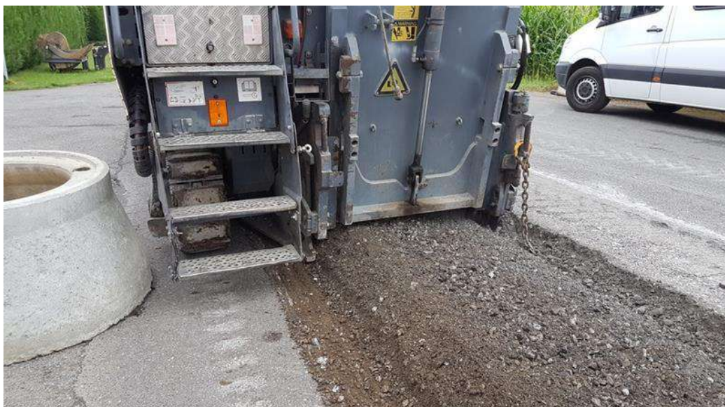
Travaux à Beuste (création du réseau de collecte EU – opération de rabotage de la chaussée)
