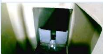
Mesure du débit de la Source Loustau à Montaut, dite de « La Mouscle », une des productions et distribution d'eau potable assurée par la CCPN et son service des eaux comme les sources de Arbéost, Ferrières et le forage de Lestelle-Bétharram.
