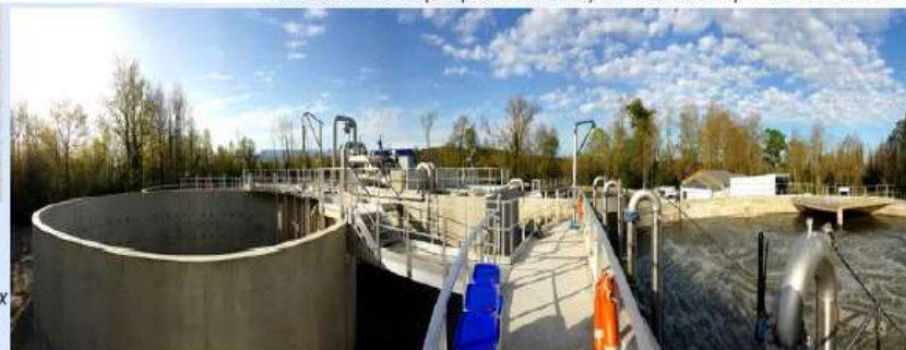
Nouveaux bassins (tampon et aération) de la station d'épuration de Baudreix
