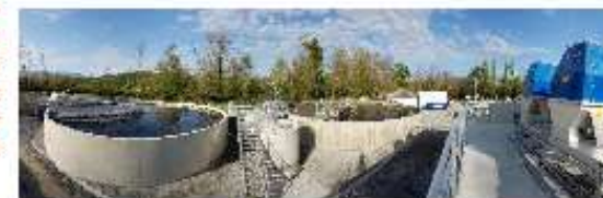
Nouvelle station d'épuration de Baudreix (20 000 EH) en service.
